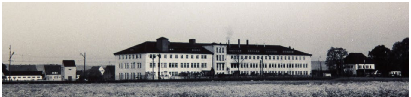
Lindnergebäude: 1948 Baubeginn des „Flüchtlingsbetriebs“
