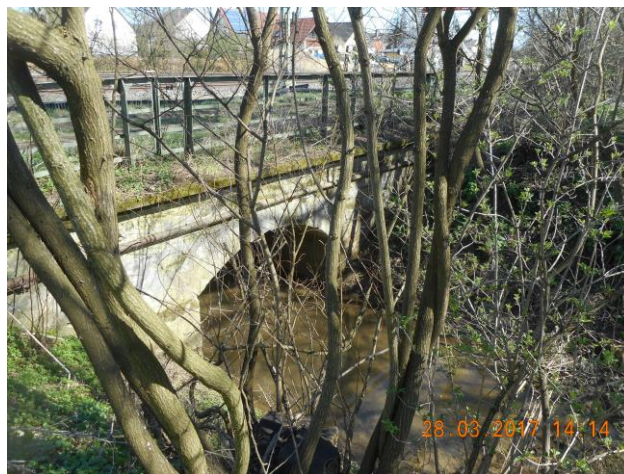
Abbildung 4-1: Bestandsdurchlass unter der Bahnlinie 1
