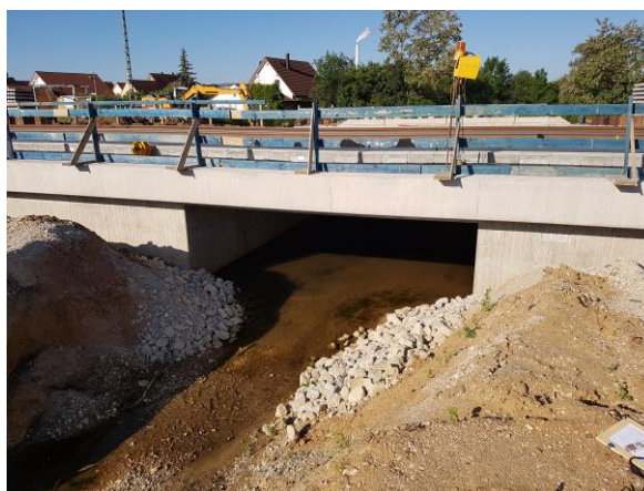
Abbildung 4-3: Neuer Durchlass unter der Bahnlinie 2
