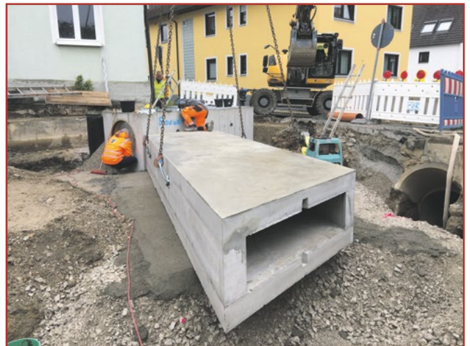
Drügendorf: Einbau Bachführung
