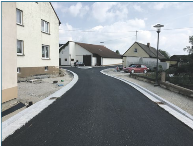
Neuses: Tiefbaumaßnahmen Bamberger Straße
