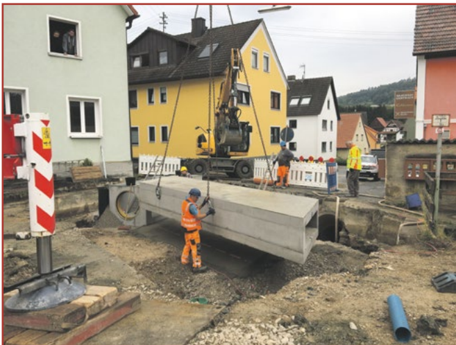
Drügendorf: Einbau Bachführung
