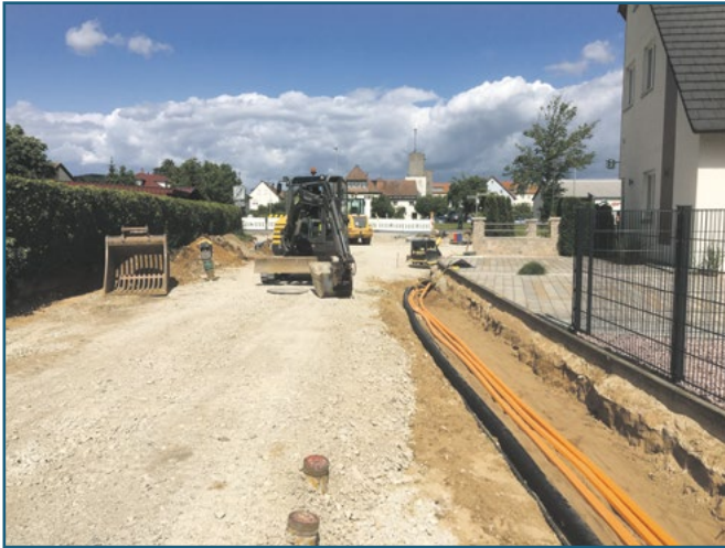
Neuses: Verlegung der Speedpipes
