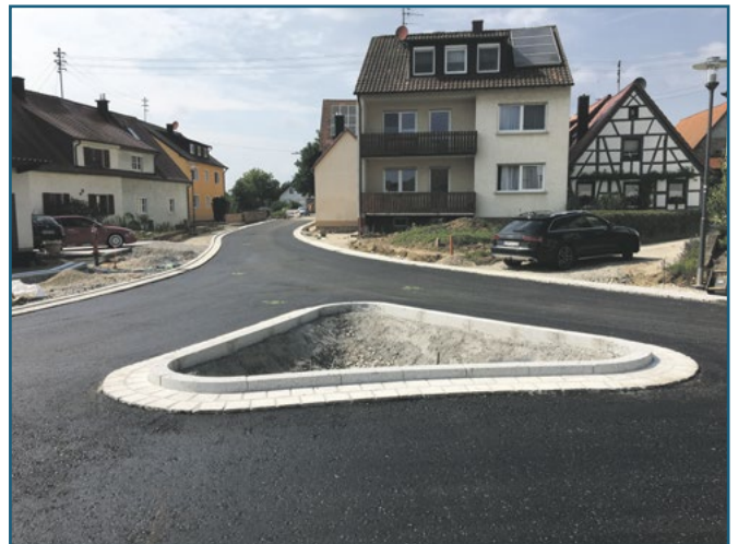
Neuses: Tiefbaumaßnahmen Ortsmitte - Bamberger Straße
