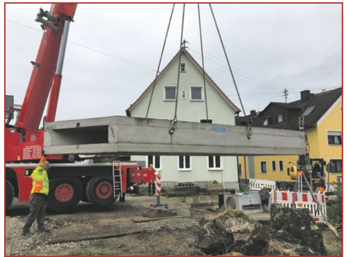
Drügendorf: Einbau Bachführung
