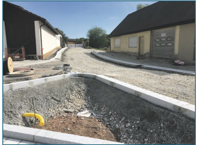
Neuses: Tiefbaumaßnahmen am Jugendtreff
