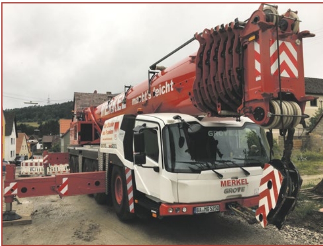
Drügendorf: Einbau Bachführung
